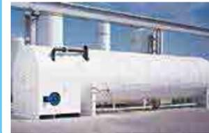
大気熱交換方式と温水を使用してLNGを蒸発させる方式などを取扱っています。
