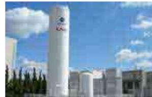
LNGの貯蔵タンクです。LNG貯槽と、内槽を複数台内蔵した複合貯槽の2種類を取扱っています。
